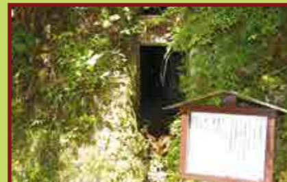
2 大多喜水道跡 千葉県最古の水道施設。江戸時代から計画され1870年(明治3年)に完成した。水路総延長 5,760m
