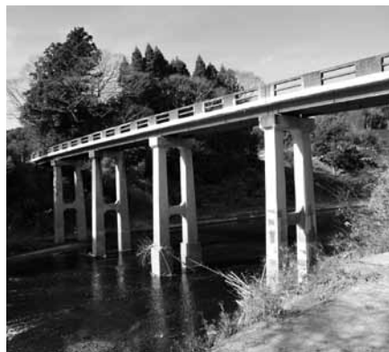
▲塩渕橋（堀之内側から）
