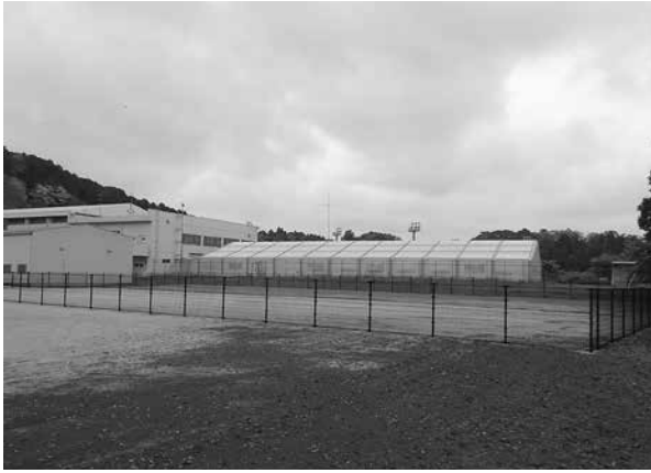
▶パンプトラック設置場所 (B&G海洋センタープール脇)
