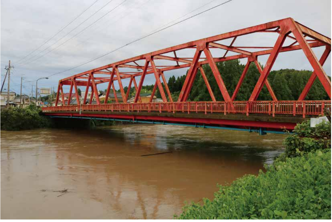
令和3年8月8日台風10号 夷隅川外廻橋付近
