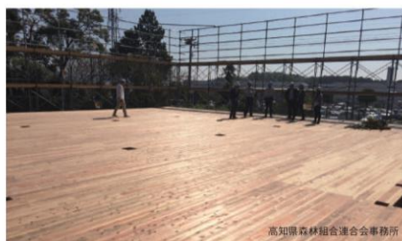
床や屋根の大きなフラットの面にCLTを使うと、大層パネルの特徴を活かした効率的な施工が可能となり、コストメリットが出やすく、工期の短縮にもつながる
