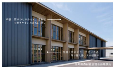
雨がかりのある部位を、木材仕上げとする場合は、腐朽や表面劣化が生じる可能性があるため、CLT等の躯体は現しにせず、仕上げの木材を取り替え易いディテールで強るとよい
