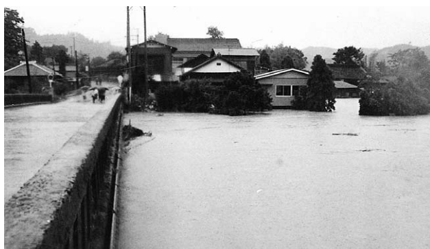
県道大多喜停車場線（三口橋付近）
