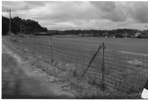
「侵入防止柵の設置」
