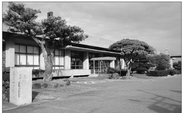
△議場がある大多喜町役場中庁舎
