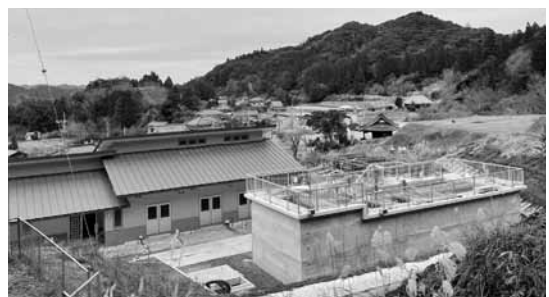
▲建設中の面白浄水場 沈殿池(手前) 管理棟(奥)
