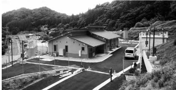
右側 沈殿池、中央 管理棟
