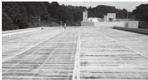
防水工事を行う中央公民館ホールの屋根
