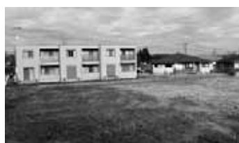
横山宮原住宅の建設用地
