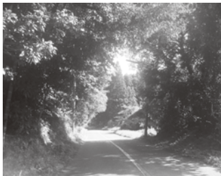
▲道路にはみ出した樹木
