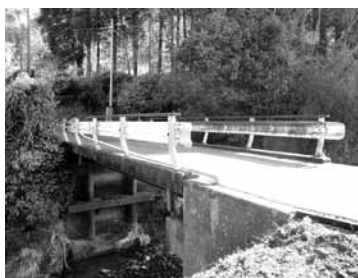
弓木地先の前堀橋
