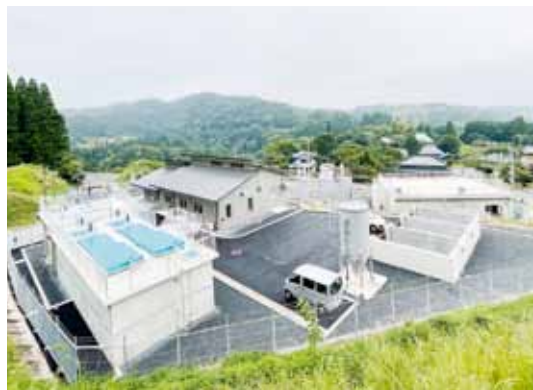
9月から稼働している新浄水場
