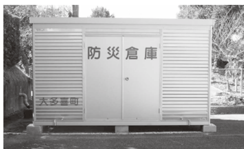
防災備蓄倉庫 (農村コミュニティセンター)
