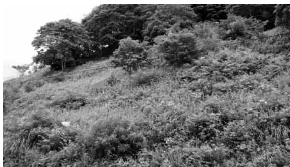
土砂災害警戒区域の指定箇所の一部
