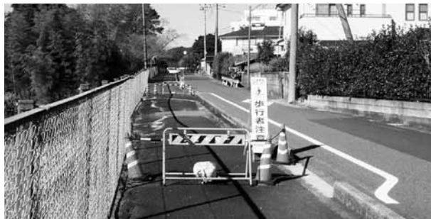
町道大中線(外廻橋から大多喜中学校方面)
