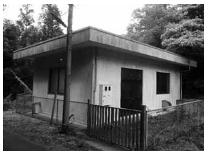
▲水道施設 横山3号井戸 (伊藤地先)
