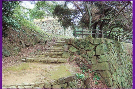
浜田城址 石垣
