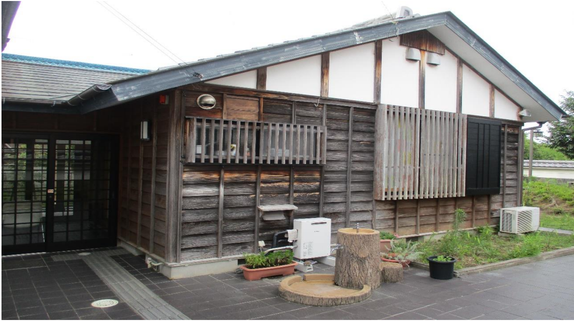
連絡通路・研修棟外観（西側）
