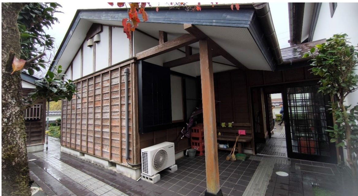
連絡通路・研修棟（東側）
