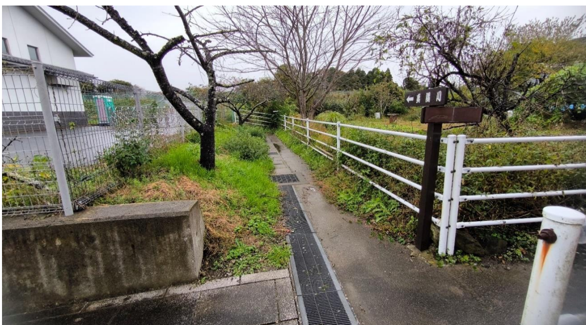
築地塀外周通路
