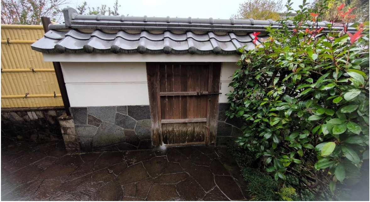
北側 築地塀出入口（内側）
