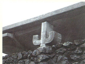
玄関ポーチ 支柱 / 若松
