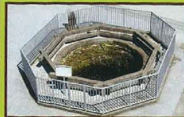
8 大井戸 (県指定史跡) 志願公が掘ったもので、水が溢れたことが ないと言われている。 深さ20m 周囲17m
