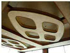
1 階会議室照明 武田菱
