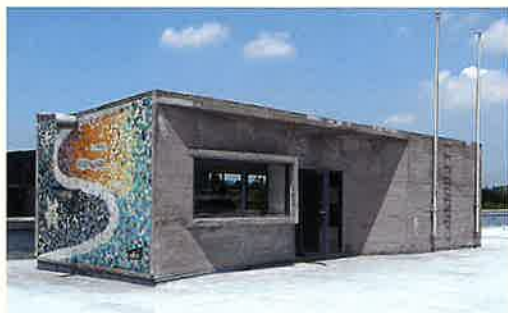
屋上ペントハウスと西壁
