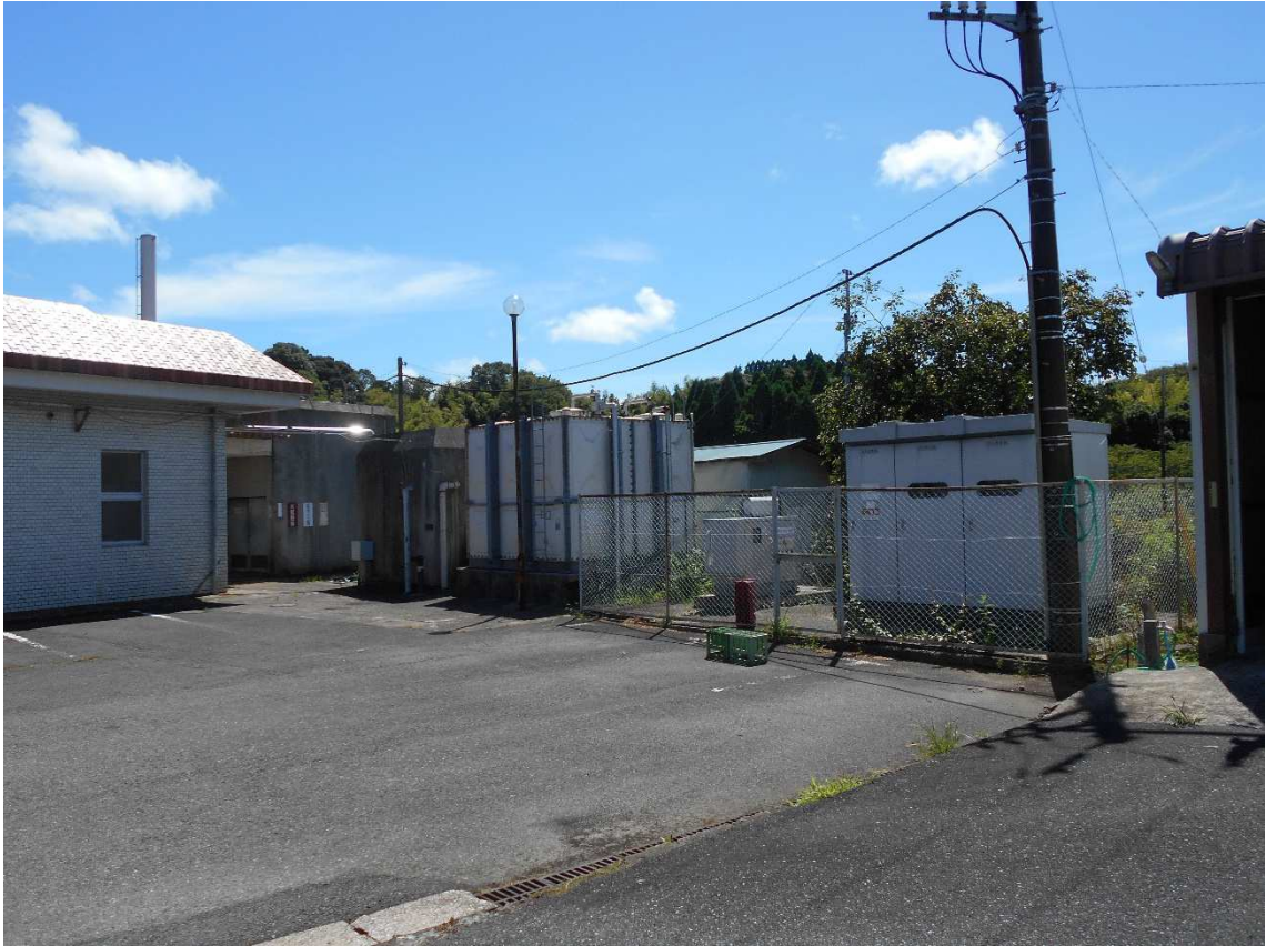
右手よりキュービクル、受水槽、ポンプ室、ボイラー室
