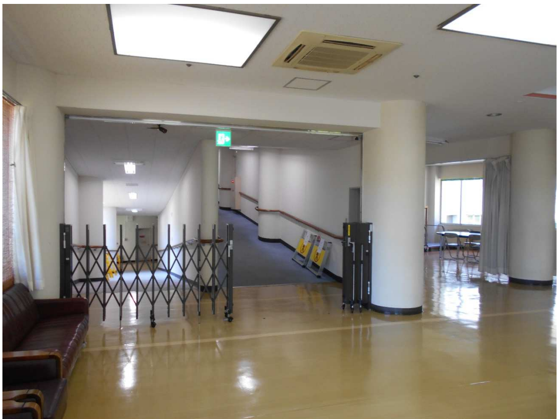
管理棟から介護棟1階、2階へ行くスロープ
