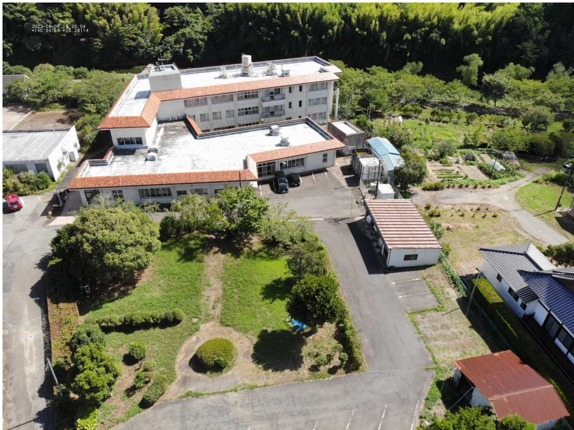
施設全景（北側より）
