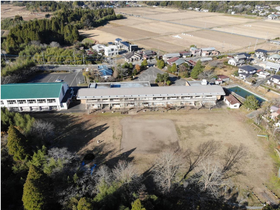
旧上瀑小学校全景（南側から）
