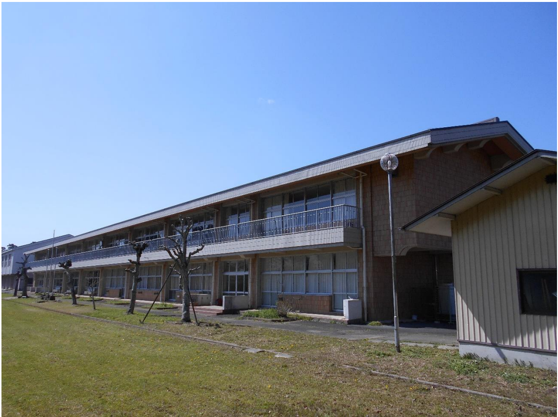
建物外観 校庭側東側
