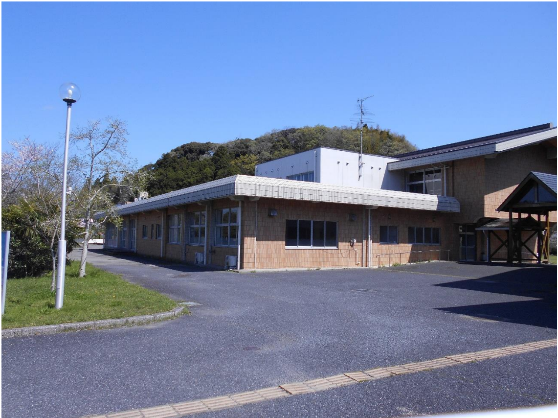
建物外観 西側
