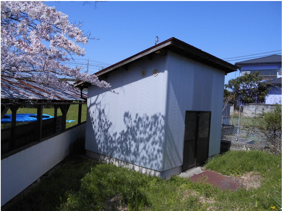
プール機械室
