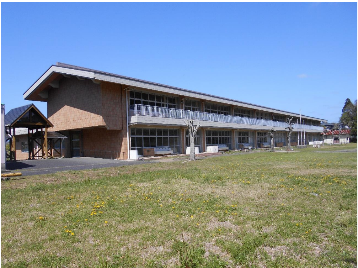
建物外観 校庭西側
